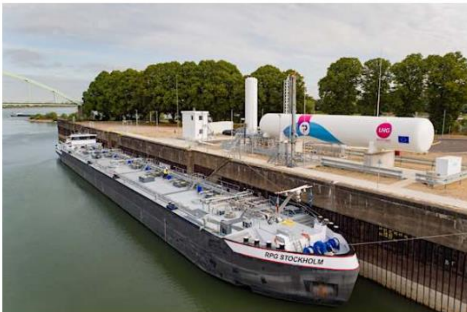
22. ábra A kölni PitPont LNG hajó töltőállomás
